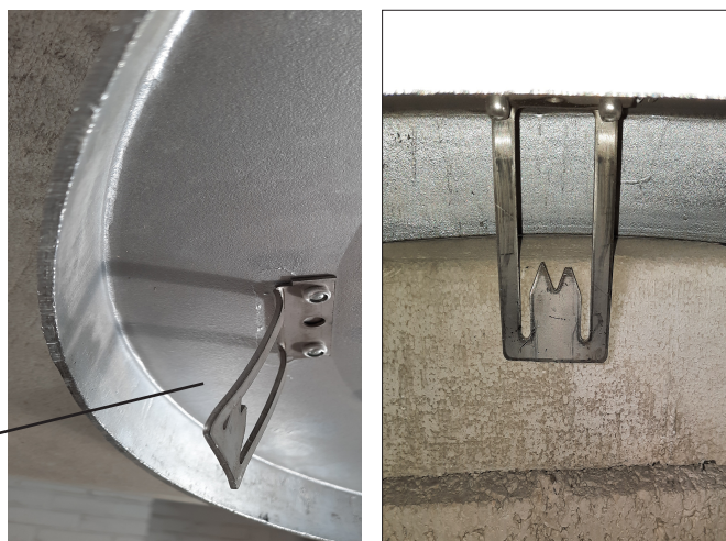
Отогните стальные зубцы так, чтобы верхнее кольцо плотно вошло в покрывную плиту.
