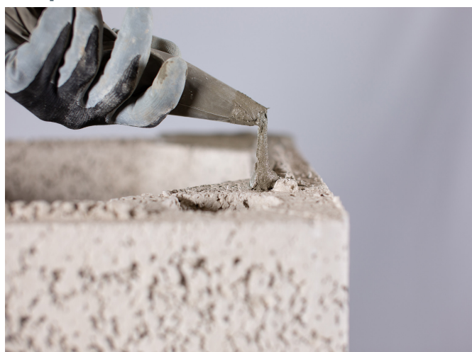
Если приобретены дополнительные блоки дымохода, просто повторите действия, показанные на стр.4, нанося слой клея для модулей между каждым блоком и плотно прижимая следующий блок на место. Убедитесь, что верхняя часть расположена ровно, и уберите излишки клея.
